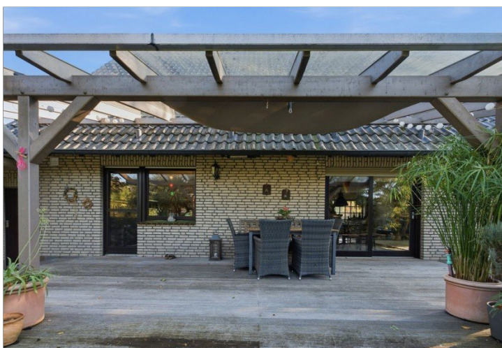
große überdachte Terrasse
