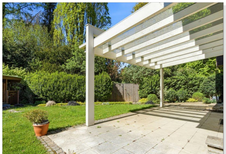
Haus-Nr. 62 - Terrasse - überdacht
