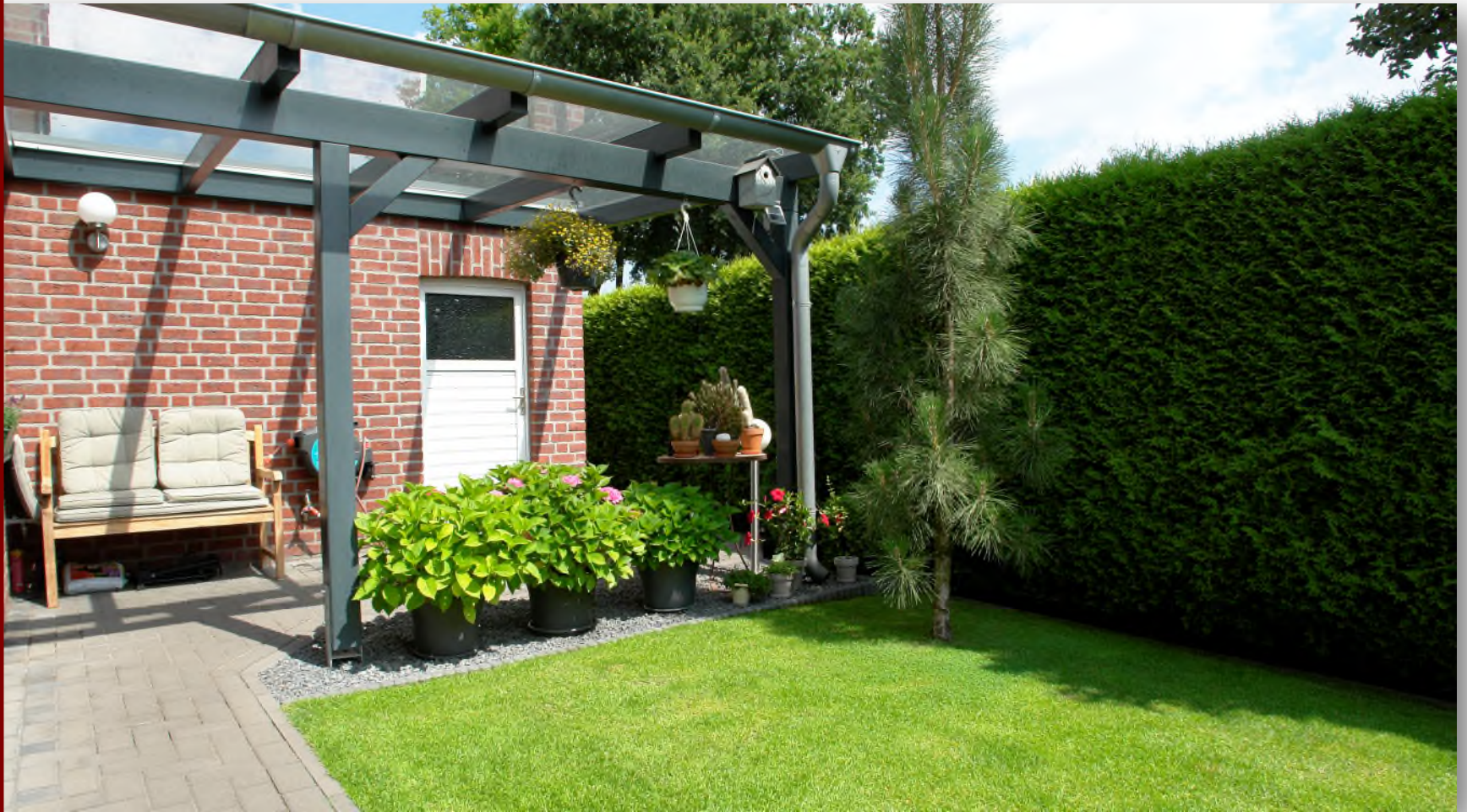
Terrasse mit Überdachung
